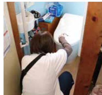
便座に腰を下ろす、腰をもち上げる時に、手すりの位置はここで大丈夫だろうか？車いすからの移動は可能だろうか？
